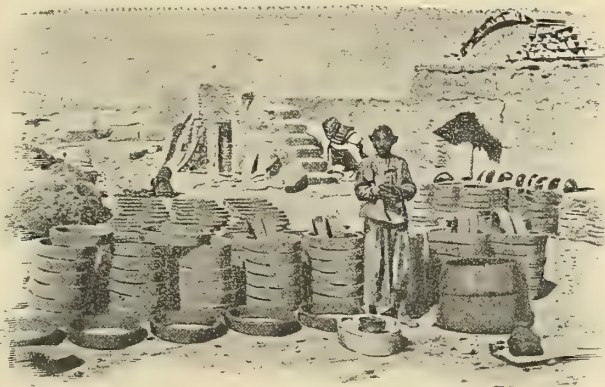
Fig. 15. — Indigènes fabriquant des anneaux en terre cuite pour conduite d'eau.
